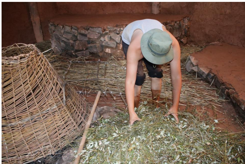
Фотосурет 3 - Ботай ғылыми-эксперименталды тұрғын үйі жылуоқшалау (теплоизоляция) жұмыстары
