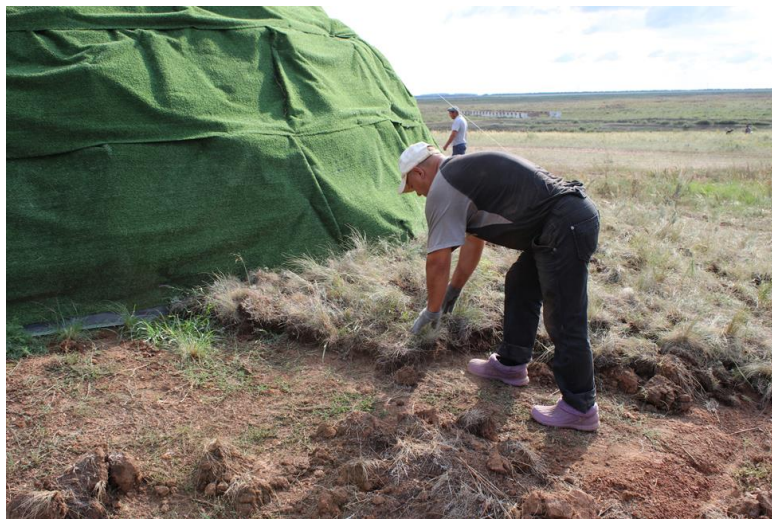
Фотосурет 4 - Ботай ғылыми-эксперименталды тұрғын үйі гидрооқшаулау (гидроизоляция) жұмыстары
